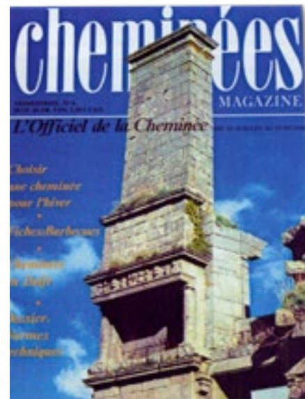
▼ Le château s'est effondré, seule la cheminée a résisté... (n°6)
